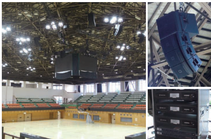
スピーカーシステム、パワーアンプ他、音響システム一式
