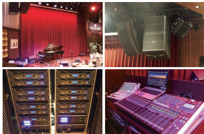
ミキシングコンソール、スピーカーシステム、パワーアンプ他、音響システム一式
